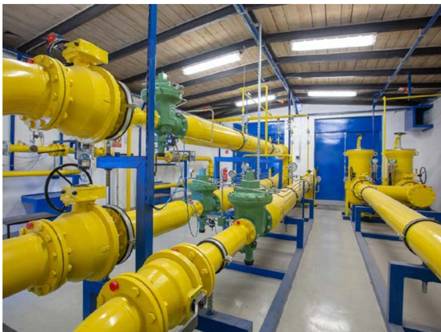
Razogljčenje plinskega sistema bo potekalo postopoma. Foto: Urban Štebljaj
